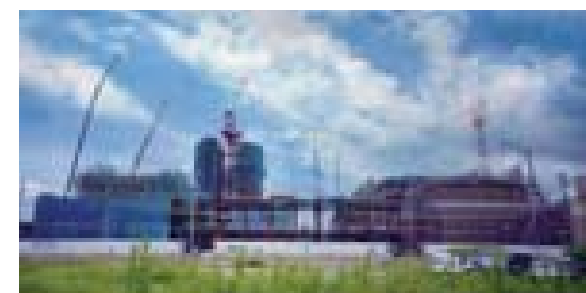
建設工事中の校舎
