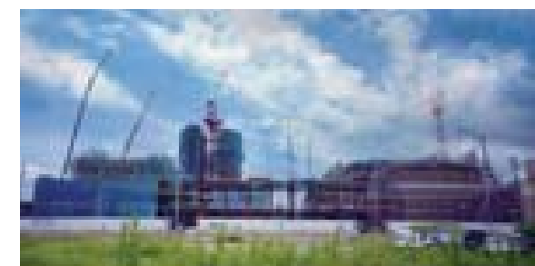
建設工事中の校舎
