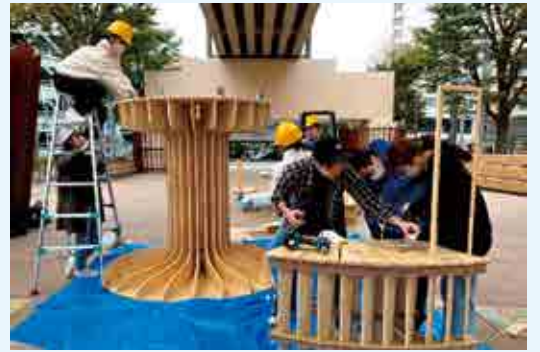
現地に搬入し最終組立て・設置の様子
