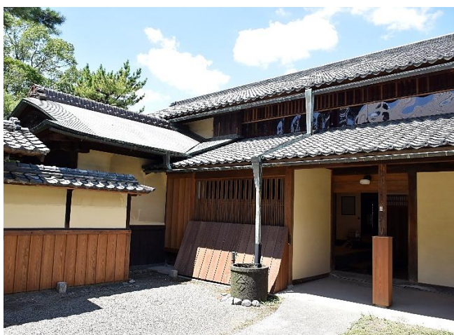
松ヶ岡（旧山崎家住宅）主屋正面
