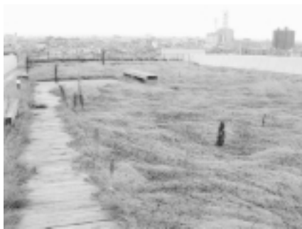
写真-4. 平成12年8月15日北棟東ブロック
