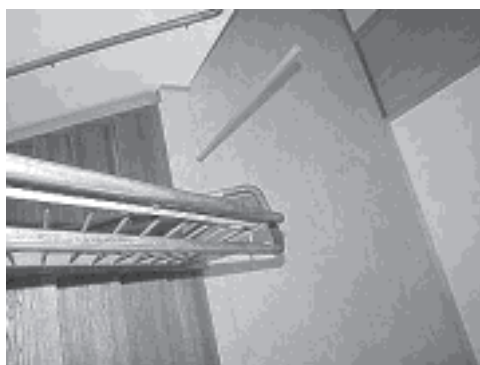
写真-5：階段に設けられた簡単な車椅子転落防止バー
