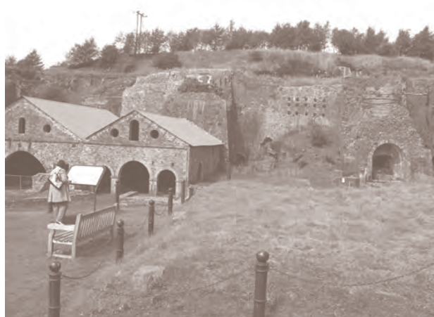
（観望地点から溶鉱炉等を望む：藤田撮影 2011.8.17）
