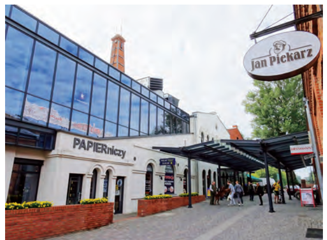
写真-4 中庭空間：右が平屋棟、左が3層のガレリア棟
