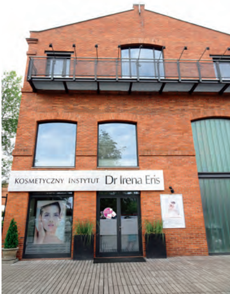
写真-5 ガレリア棟外観
