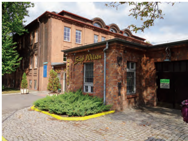
写真-44 入り口（旧炭坑のゲート）
