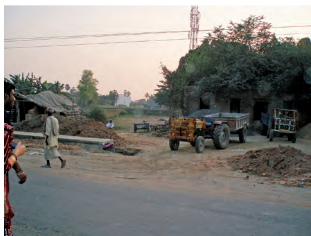
写真7：伝・アーザル・カイヴァーン廟跡のヒンドゥー教寺院工事現場
