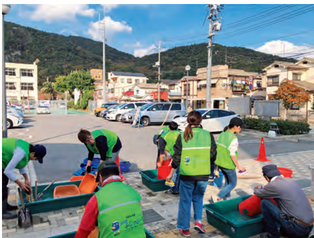
写真5・6・7： 家屋下の泥のかき出し作業と終了後の片付けの様子
