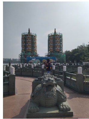
↑ まだ工事中の龍虎塔
